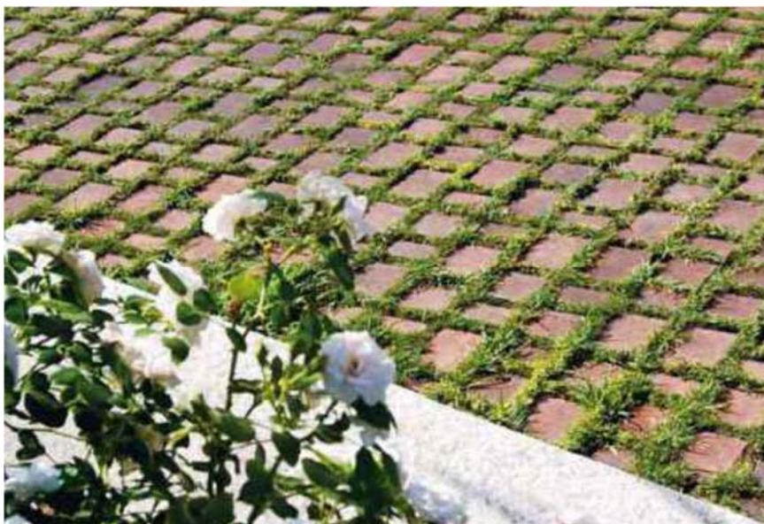
LASTRICATO ERBOSO ALTAMENTE DRENANTE REALIZZATO CON MATERIALE FOTOCATALITICO PER LA PAVIMENTAZIONE DELLE AREE CARRABILI;
